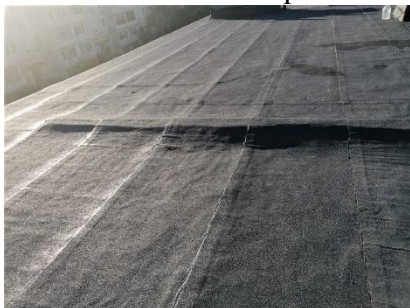
Наша новая кровля.
