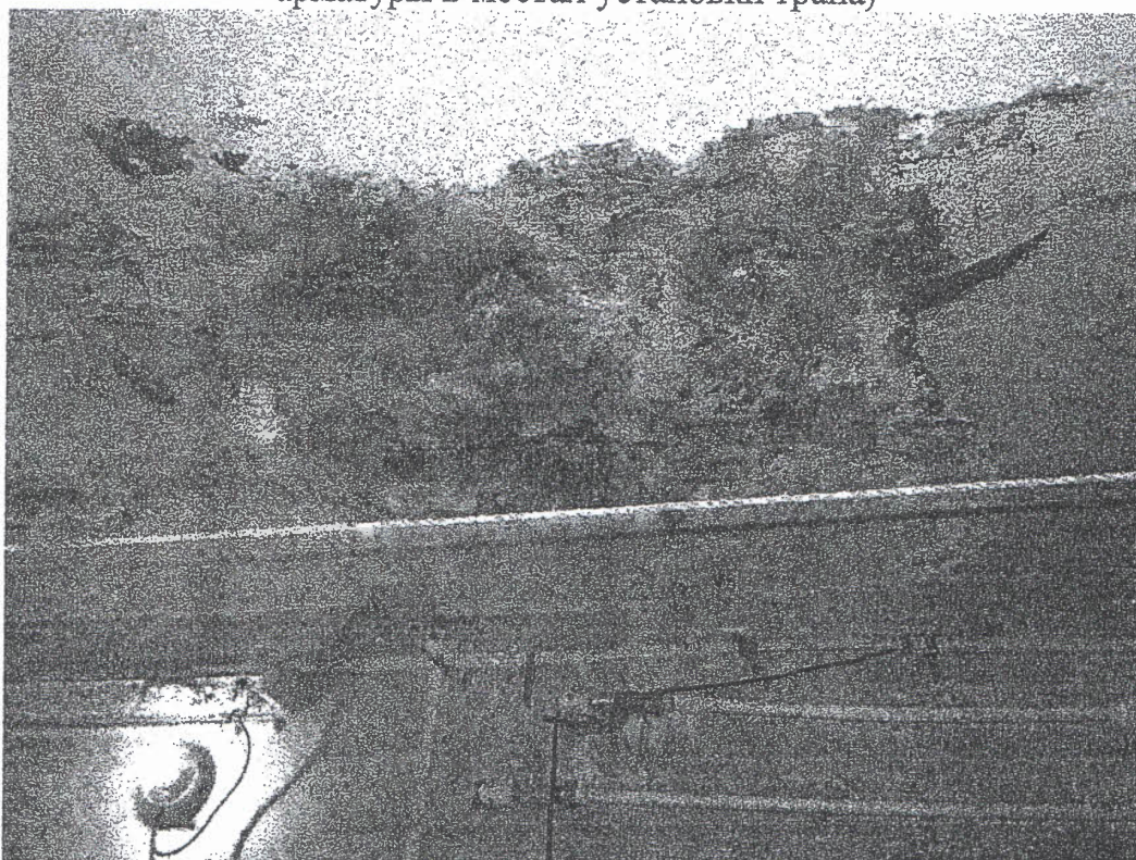
Фото №10 (4 этаж, перекрытие умывальной, разрушение бетона, коррозия арматуры в местах установки трапа)
