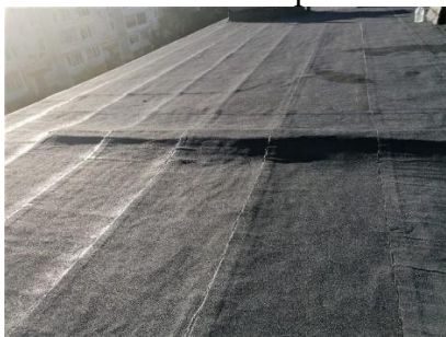
Наша новая кровля.
